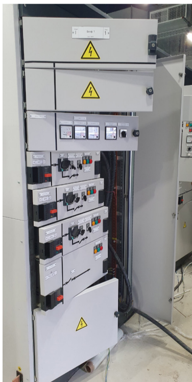
Распределительное устройство низкого напряжения, помещение электрощитовой подстанции
