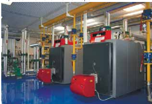
Оборудование котельной
