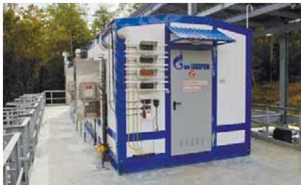
АГРС Адлерского района города Сочи. Блок-боксы аналитические.
