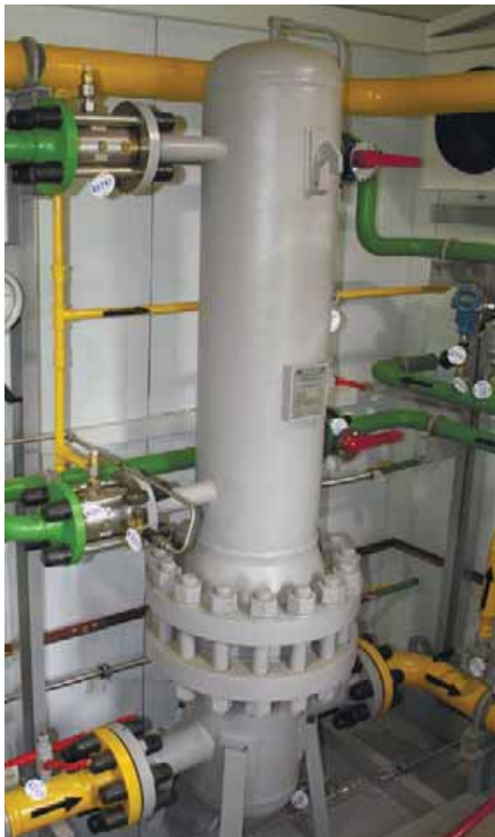
Теплообменник газовойдвойной ТГВ-100/7,5
