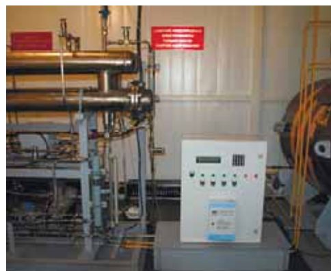
Блок-бкс блока одоризации на СУГ
