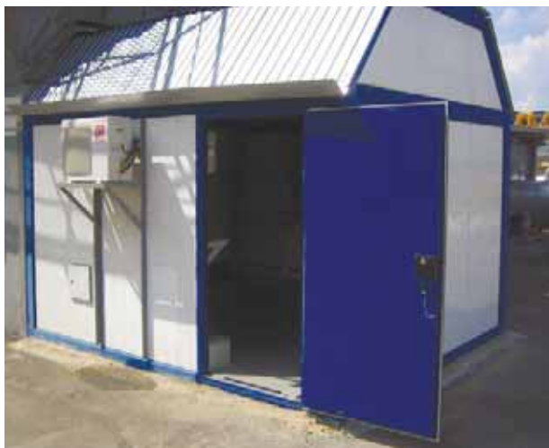
Аппаратный блок-бокс САУ ГПА «Неман-Р»
