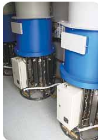
ТЭГ-500 (с жидкостным охлаждением)
