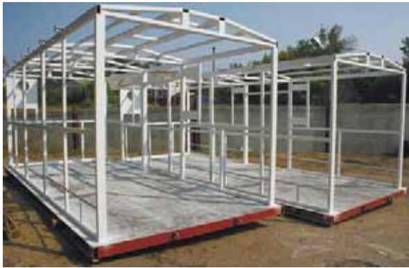
Каркас блок-контейнеров
