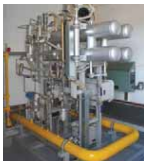
Блок одоризации в отсеке блок-букса переключения
